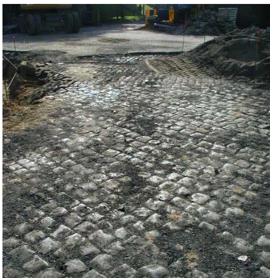
Watermael : démontage de pavés de porphyres sous asphalte et réutilisation
