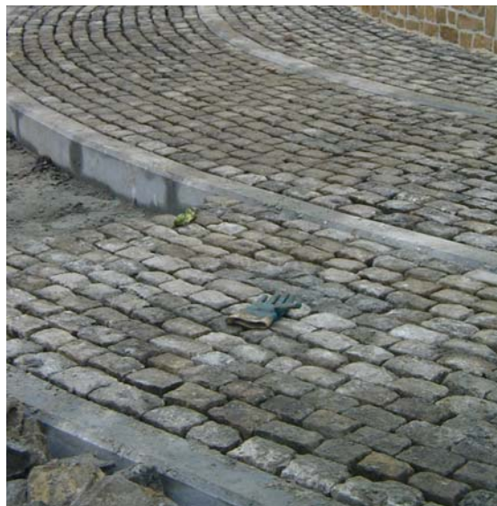
Watermael : démontage de pavés de porphyres sous asphalte et réutilisation
